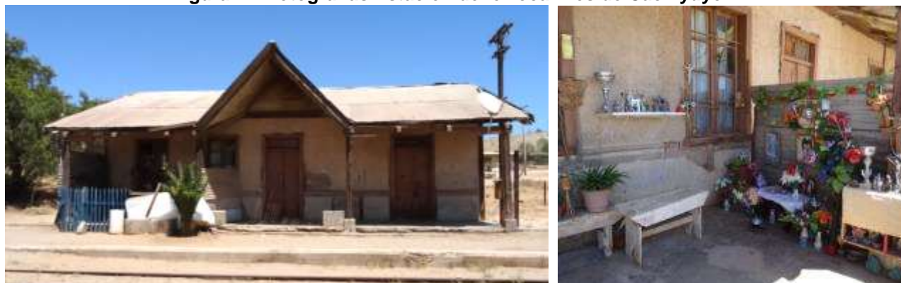
Figura 21. Fotografías Estación de ferrocarriles de Cachiyuyo
